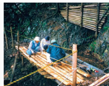
始神峠の橋の整備の様子
