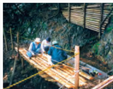
始神峠の橋の整備の様子
