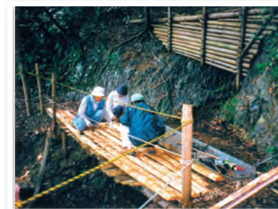
始神峠の橋の整備の様子
