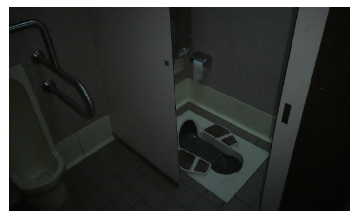
男子トイレ和式トイレ（1基）
